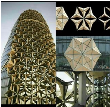
تصویر ۷: تصاویری از برج البحر (Ulr ۳ )
