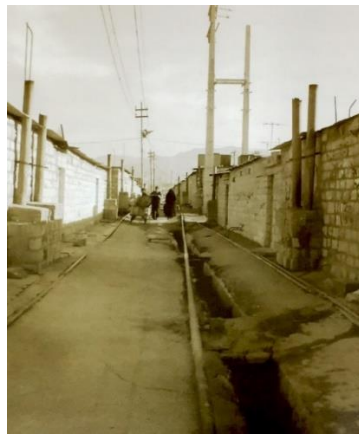
شکل (۴) لوله‌های دودکش منازل شرکتی
